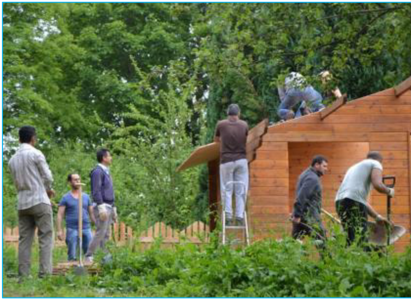
Dachbau und Gartenarbeiten
